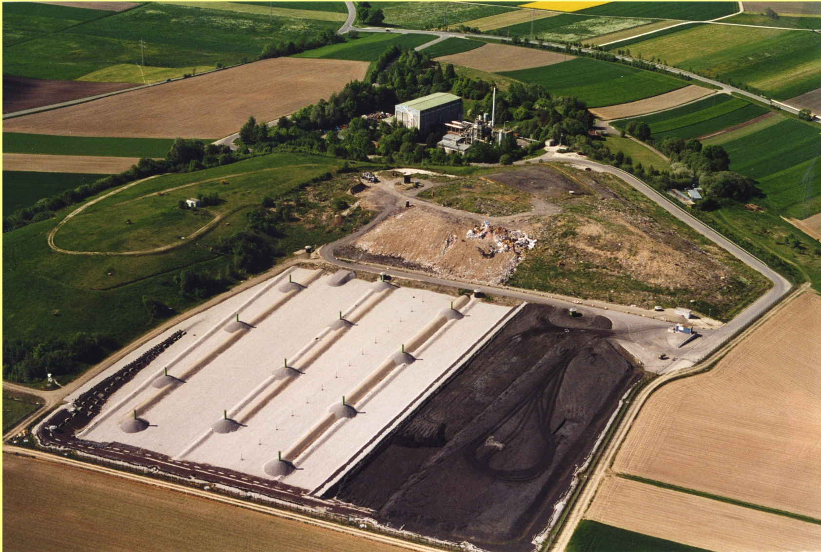
Müllpyrolyseanlage (MPA) Burgau mit Deponie für feste Rückstände
